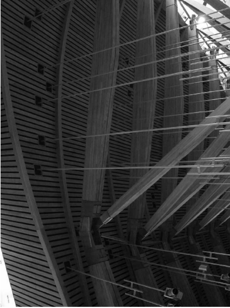
(d) Truss system (Scottish Parliament)
