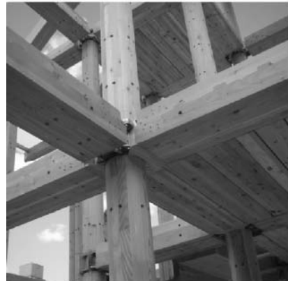
(d) Beam and post construction
